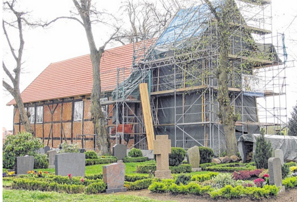
Seit diesem Frühjahr ging die Sanierung mit den Arbeiten am Turm in eine neue Runde.
